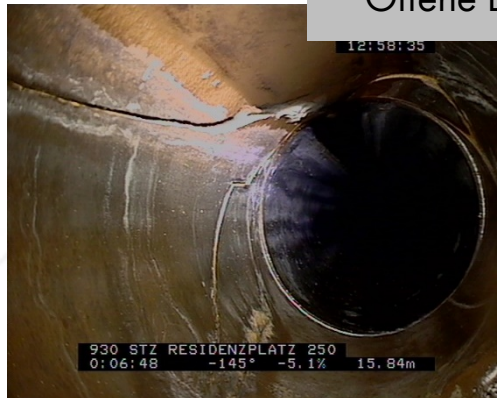
Sanierung 2020 Offene Bauweise
